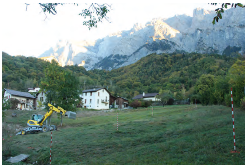
Fig. 2. Situation générale du site avant le sondage. Vue vers le nord.
